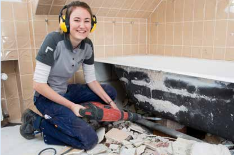
Nica Schmedding, Auszubildende zur Anlagenmechanikerin für Sanitär, Heizung und Klima im Unternehmen Blomberg Heiz- und Sanitärtechnik
